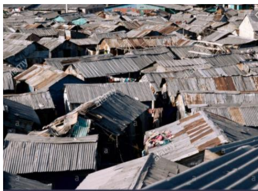
Image 5: toiture en tôle des habitats en 1990
