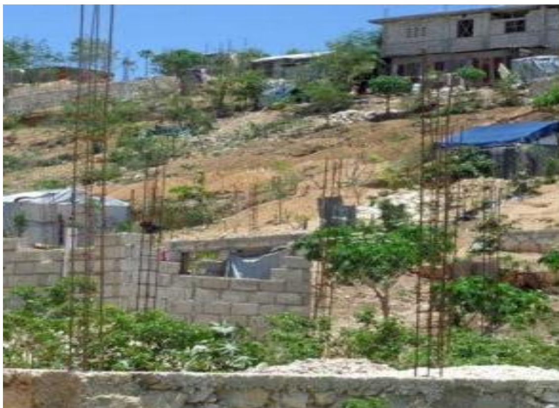
Figure 73 : Début de construction d'un habitat permanent
