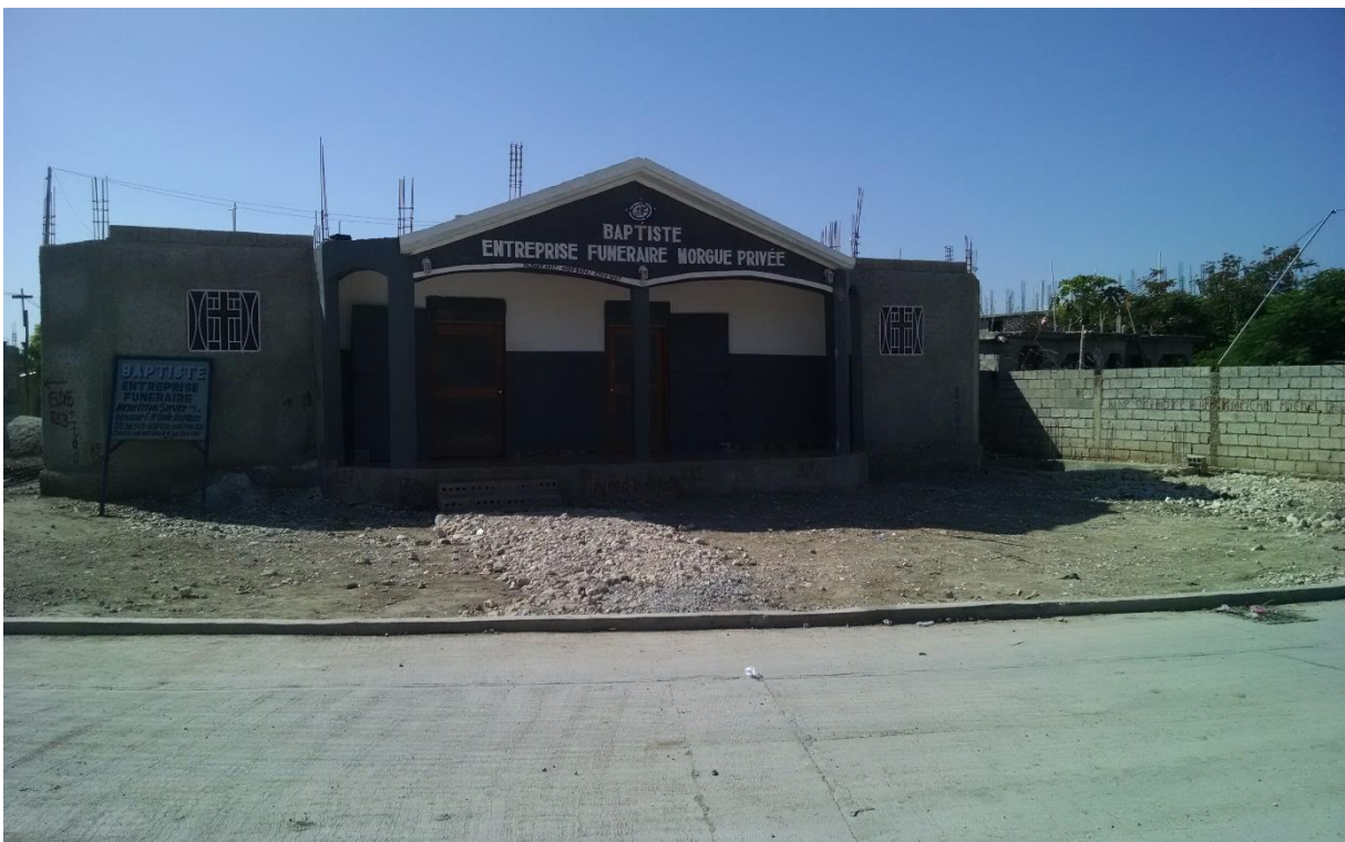
Figure 61 : Entreprise funéraire Baptiste dans le sous-quartier Canaan 3
