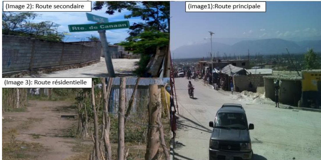
Figure 45 : Infrastructures routières à Canaan
