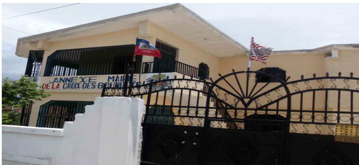
Figure 52 : Annexe principale de la mairie des Croix-des-Bouquets
