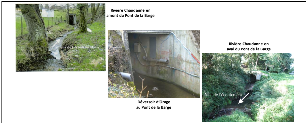
Figure 23 : Présentation de la zone à proximité du Pont de la Barge (Photos : [Gnouma, 2006] ; Angerville, 2008)
