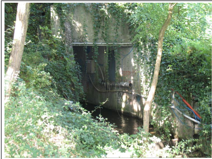
Figure 53 : Scénario français - Déversoir d'orage (DO) déversant des RUTP dans la rivière Chaudanne
