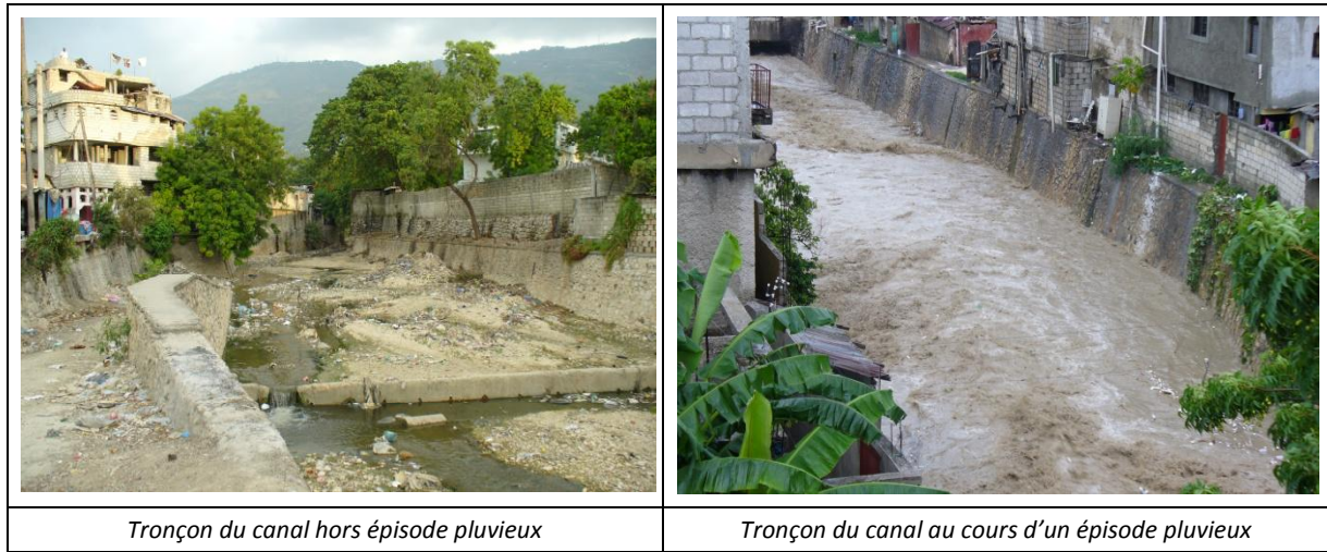
Figure 54 : Scénario haïtien - Vues du Canal Bois-de-Chêne à Port-au-Prince hors épisode pluvieux et au cours d'un épisode pluvieux (photos : Angerville, 2008)
